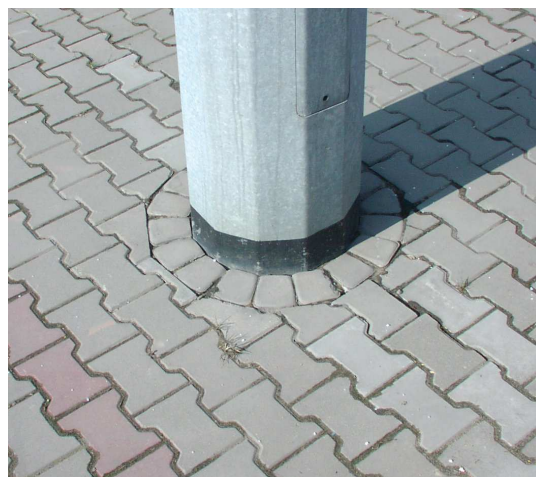
Fot.1-2 Detal obróbek wokół słupa i studzienki kanalizacyjnej
