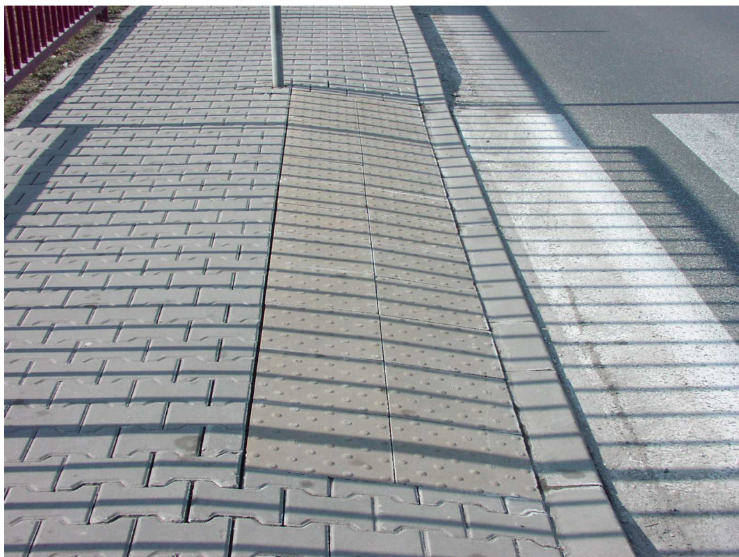
Fot.7 Przykładowa nawierzchnia chodnika ze spadkiem dla osób niepełnosprawnych
